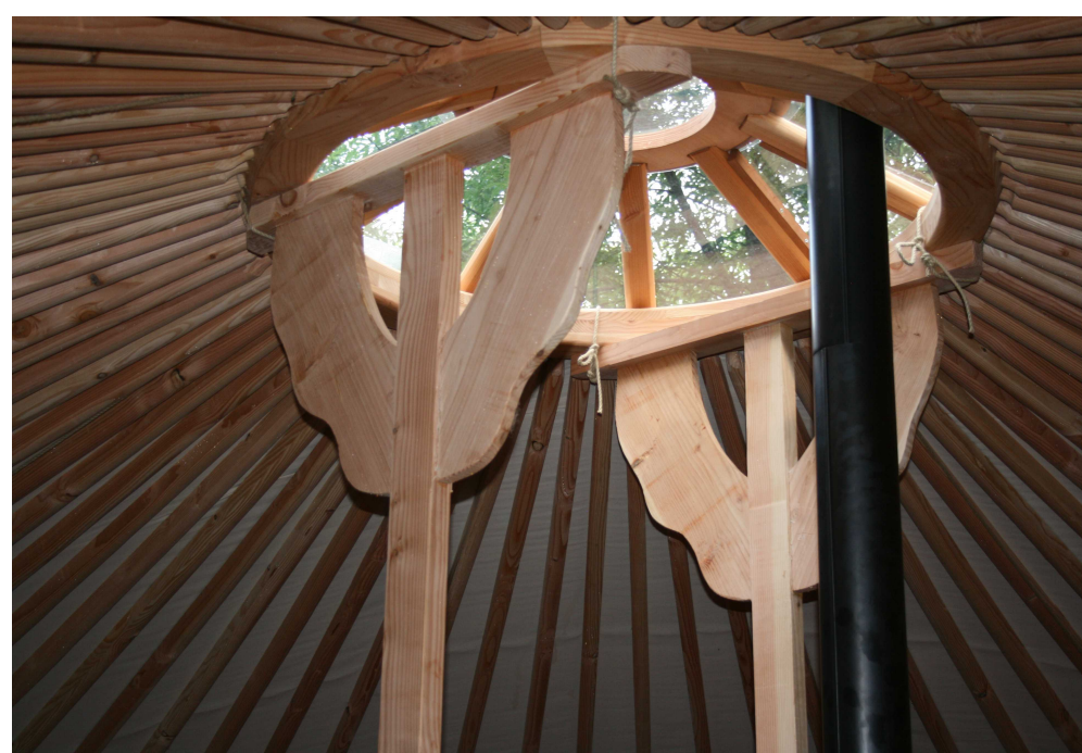
Predisposizione uscita stufa centrale
